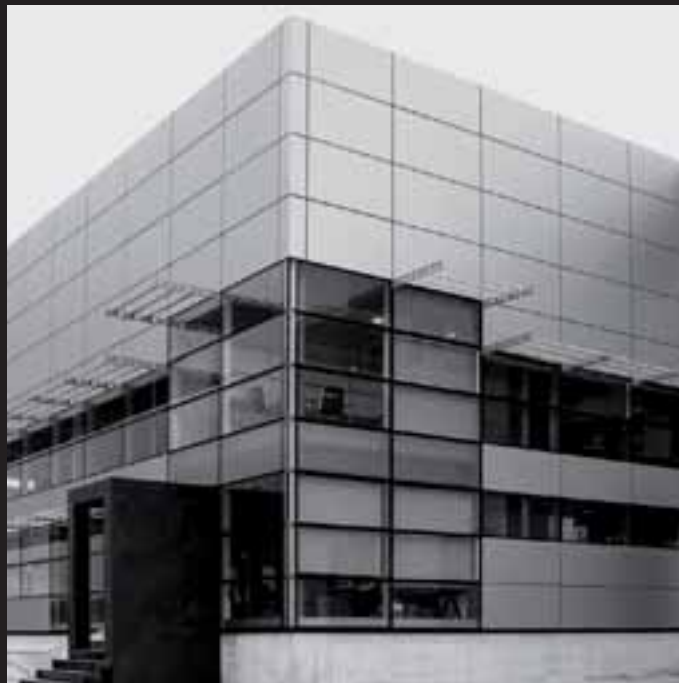
Oficinas centrales Molina de Segura (Murcia, Spain).
