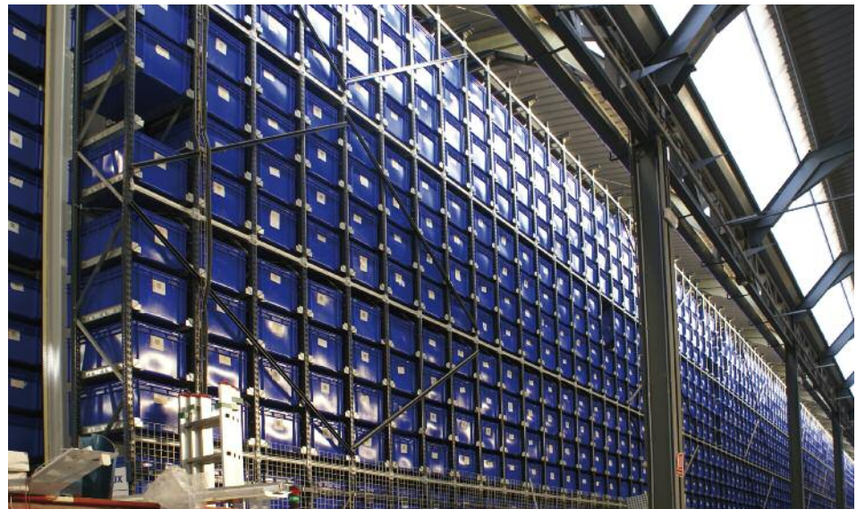
Sistema de almacén y dispensación robotizada de productos / Robotized warehousing system.
