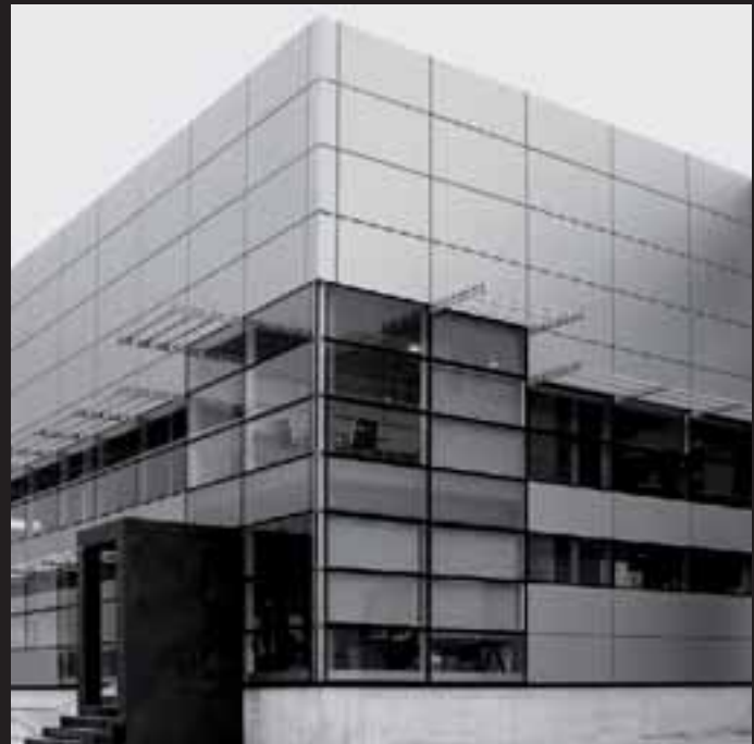
Oficinas centrales Molina de Segura (Murcia, Spain).
