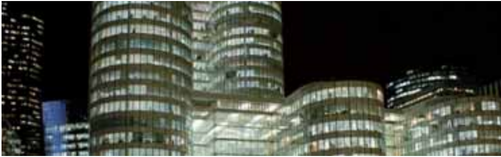
Éclairage urbana et routière
