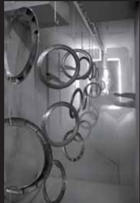
Instalação automática de tunel de pré-tratamento de desengorduramento e desfosfatação, cabine de pintura em pó automática e forno de polimerização.
