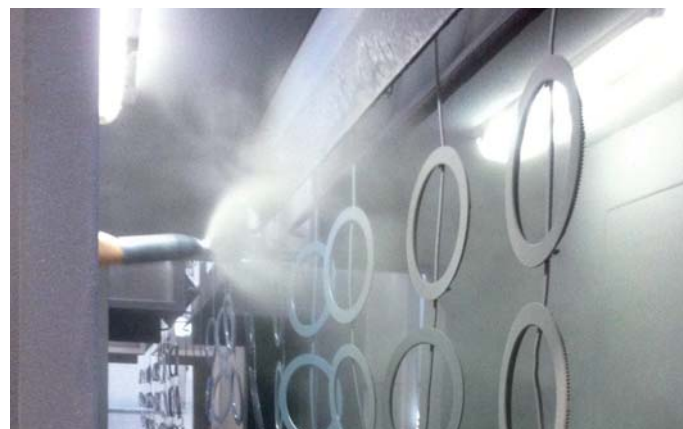
Instalación automática de túnel de pretratamiento de desengrasado y desfosfado, cabina de pintura en polvo automática y horno de polimerizado. Automatic installation of tunnel for defosfating and degreasing, powder coating booth and polymerization oven.
