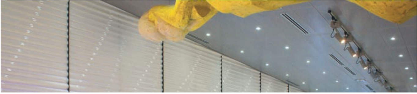
Iluminación interior Indoor lighting
