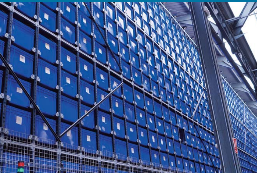
Sistema di immagazzinaggio robotizzato. Sistema de armazenamento robotizado.
