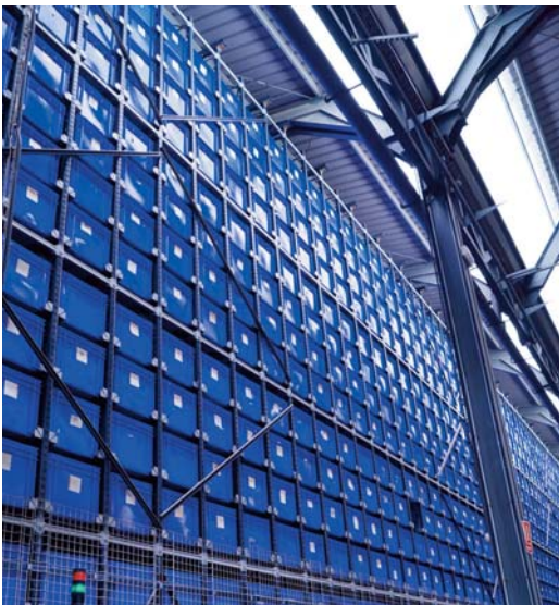
Sistema de almacén y dispensación robotizada de productos. Robotized warehousing system.
