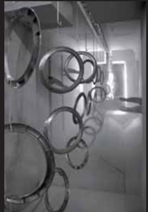
Istallazione automatica di tunnel di pretrattamento di desgrassamento e desfosforizzazione, cabina di verniciatura in polvere automatica e forno polimerizzato.
