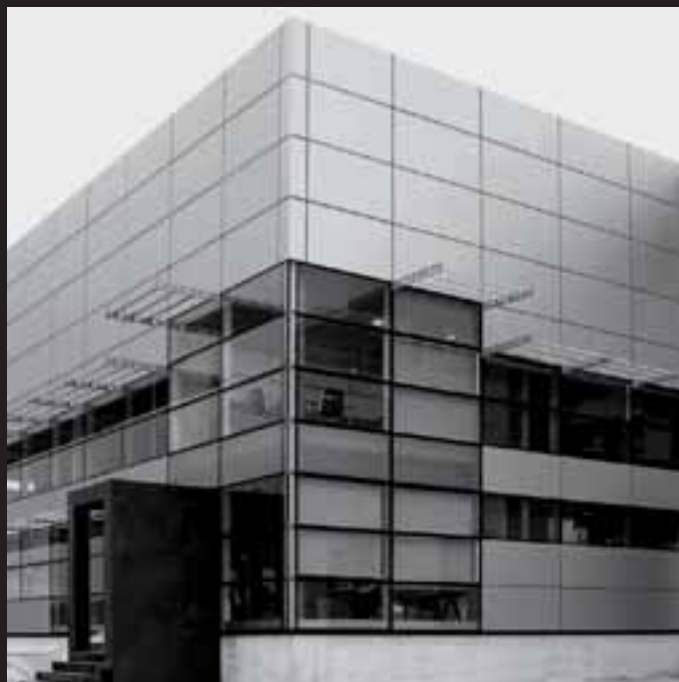
Uffici centrali a Molina de Segura (Murcia, Spain).
