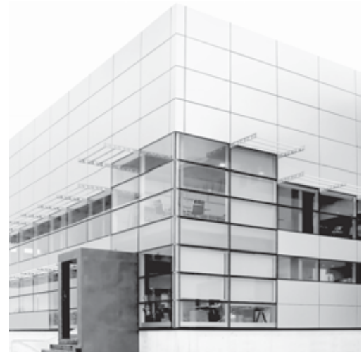
Oficinas centrales Molina de Segura (Murcia, España). Head Office Molina de Segura (Murcia, Spain).
