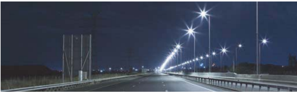
Iluminación urbana y vial Urban street lighting
