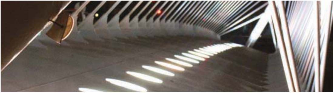
Iluminación exterior Outdoor lighting
